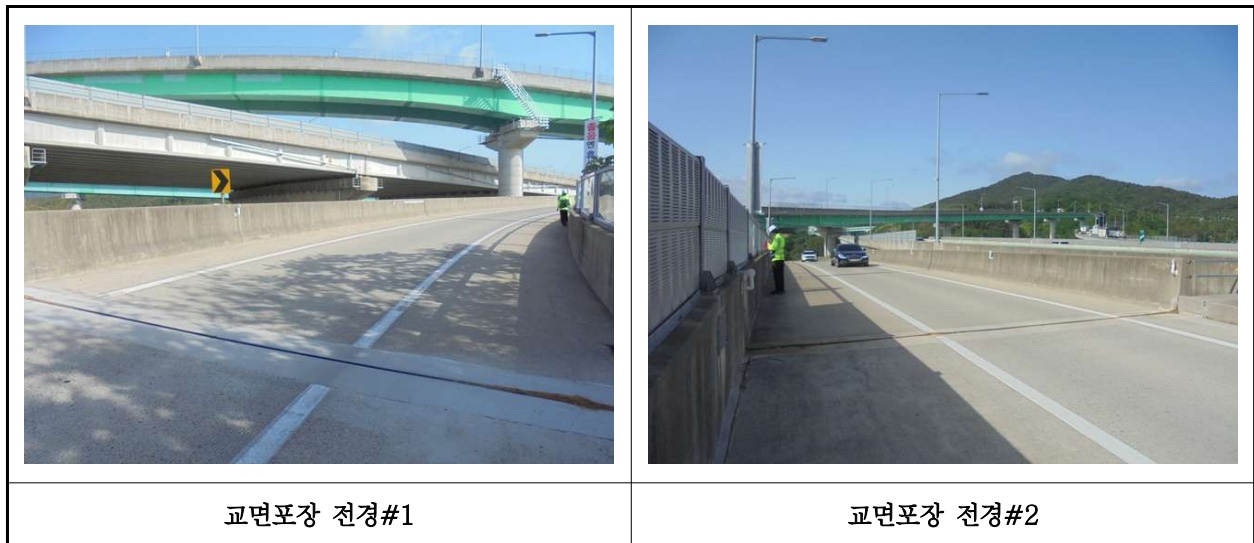
【사진 37.3.20】 교면포장 전경
