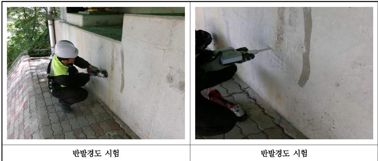
【사진 37.4.2】 반발경도시험 현장사진
