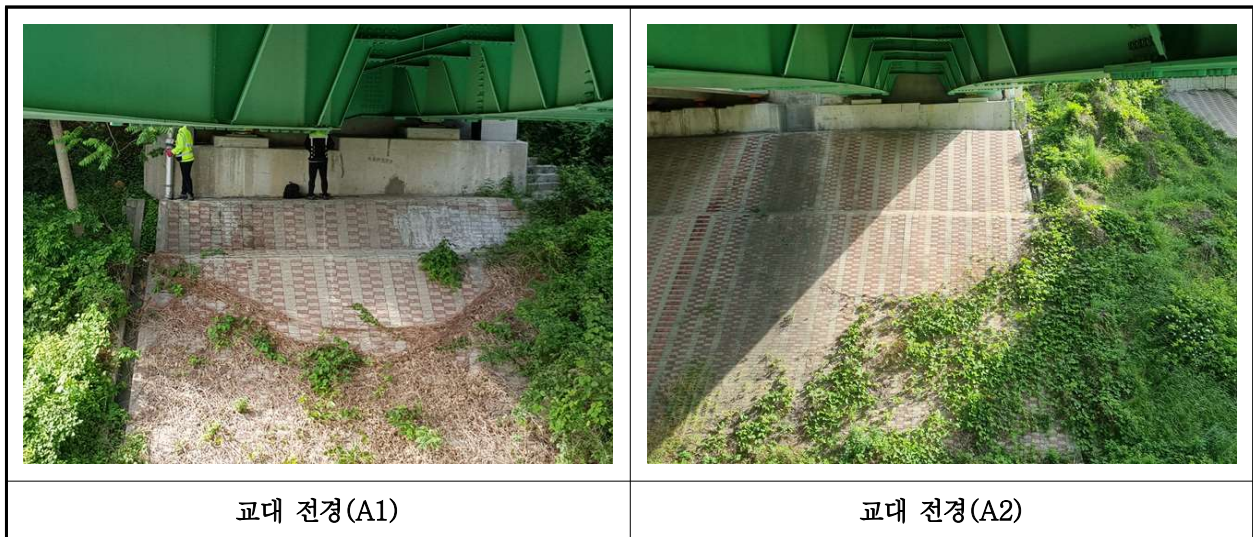
【사진 37.3.8】 교대 전경
