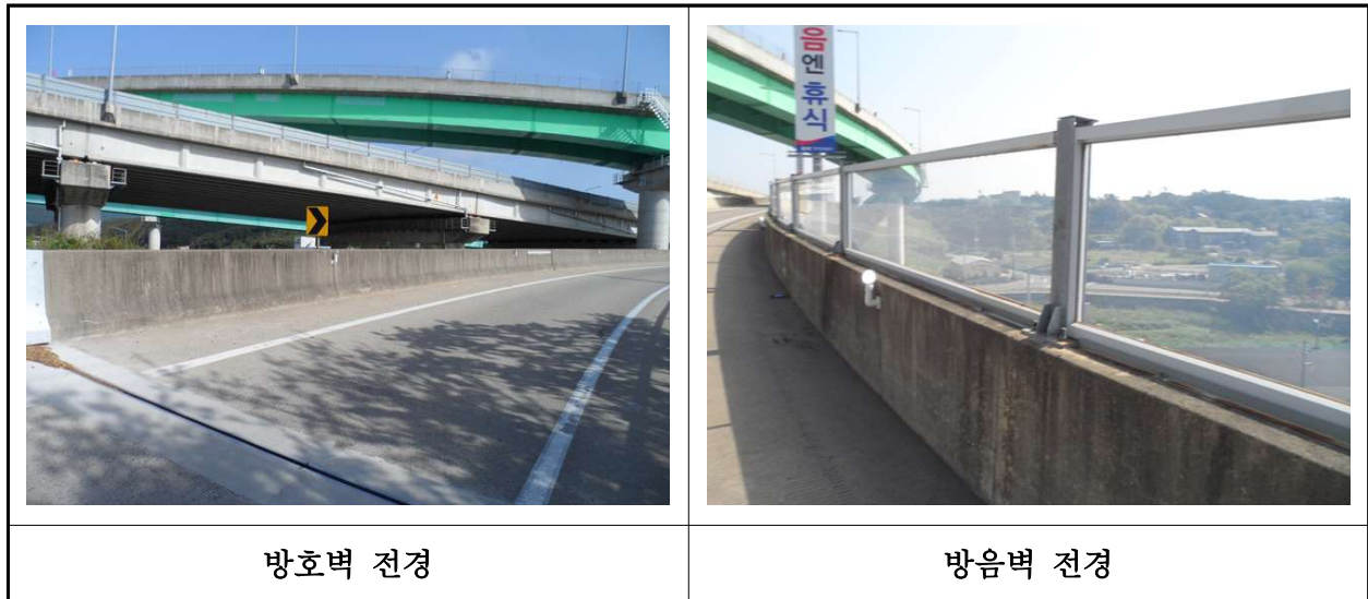
【사진 37.3.24】 방호벽 및 방음벽 전경
