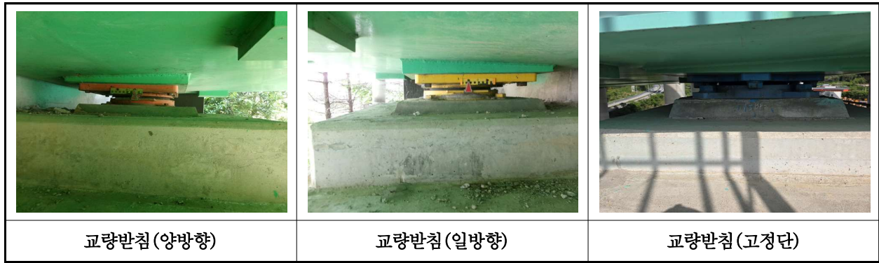
【사진 37.3.13】 교량받침 전경
