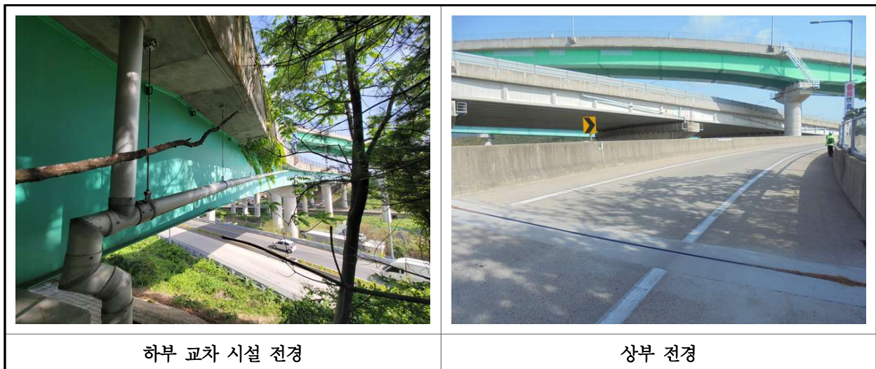
【사진 37.2.1】 주변환경 및 하중변화 전경
