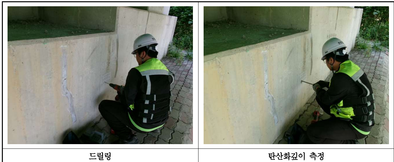
【사진 37.4.3】 탄산화 깊이 측정 현장사진
