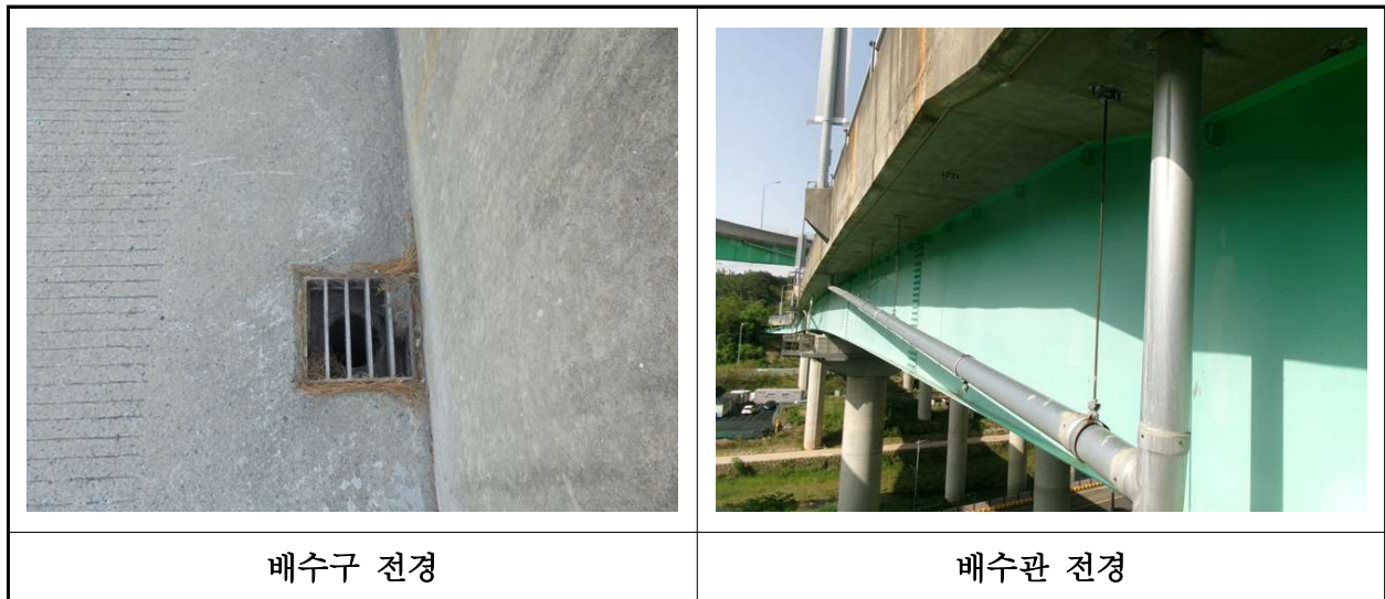
【사진 37.3.22】 배수시설 전경
