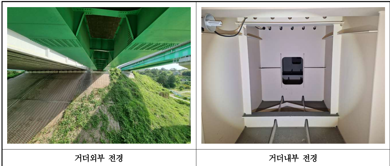
【사진 37.3.4】 거더 전경
