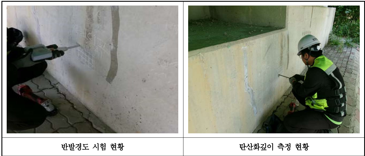
【사진 37.4.1】 콘크리트 내구성조사 현황
